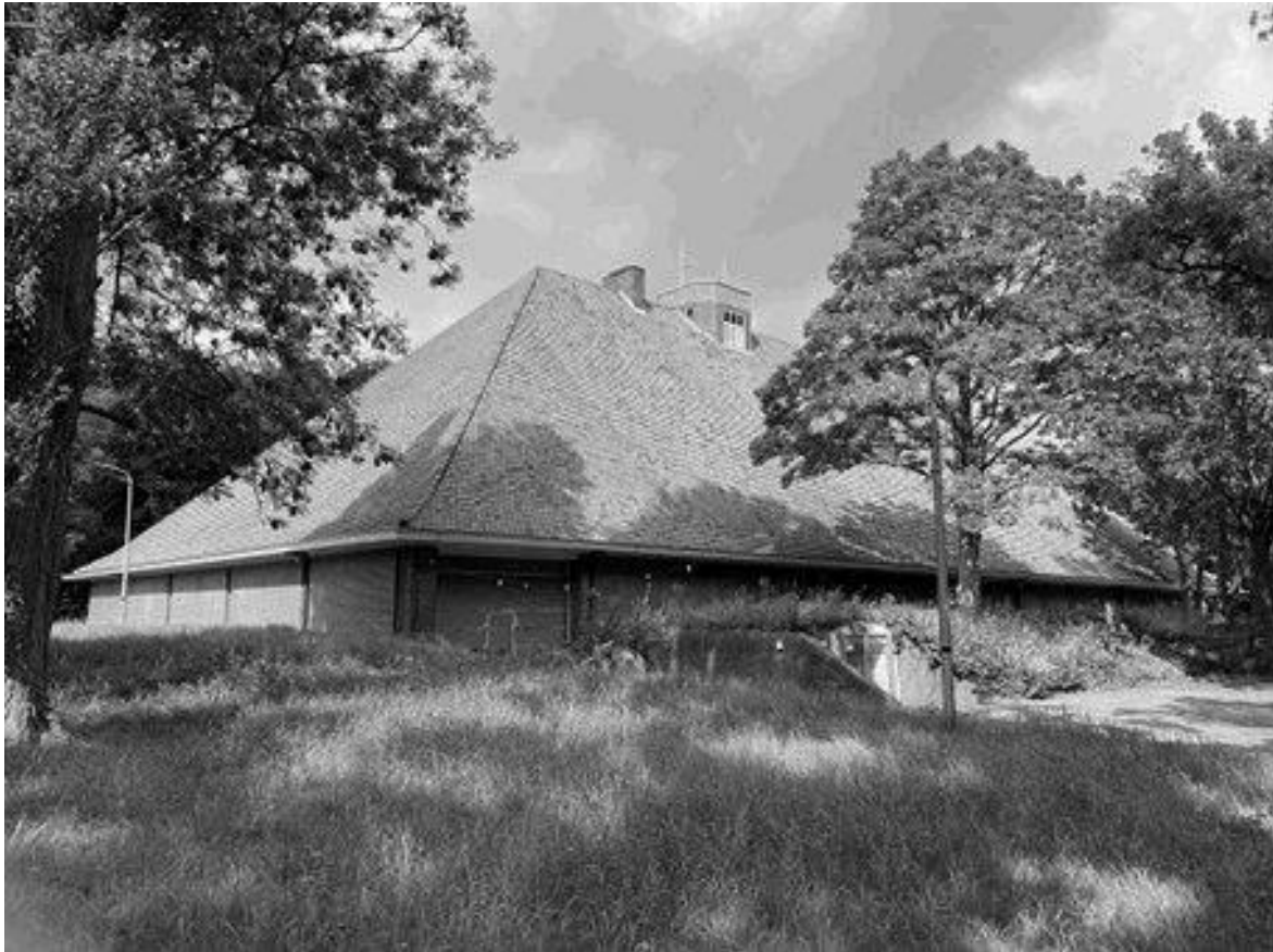
De bunker van Seyss-Inquart lijkt uit de verte op een boerenschuur. Foto: Mariëtte van Lit.
